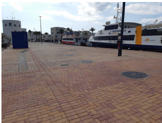
Foto 4. Arquetas de depósitos de combustible.
