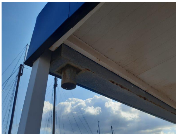
Foto 9. Bajante de aguas pluviales
