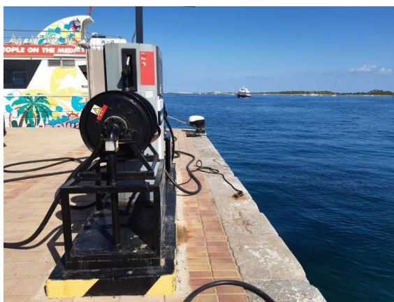
Foto 6. Zona donde se suministra combustible a las embarcaciones.
