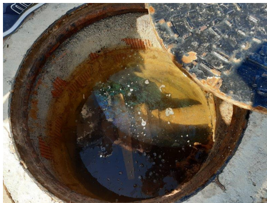
Foto 3. Arqueta de depósito
